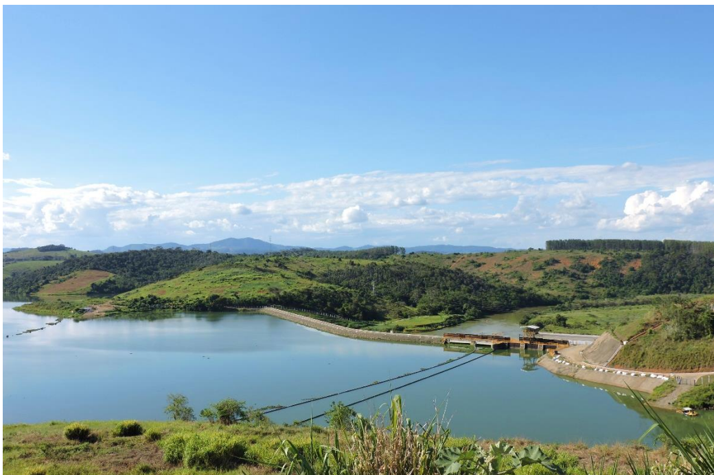
Figura 2 – Vista a montante da UHE Barra do Braúna
