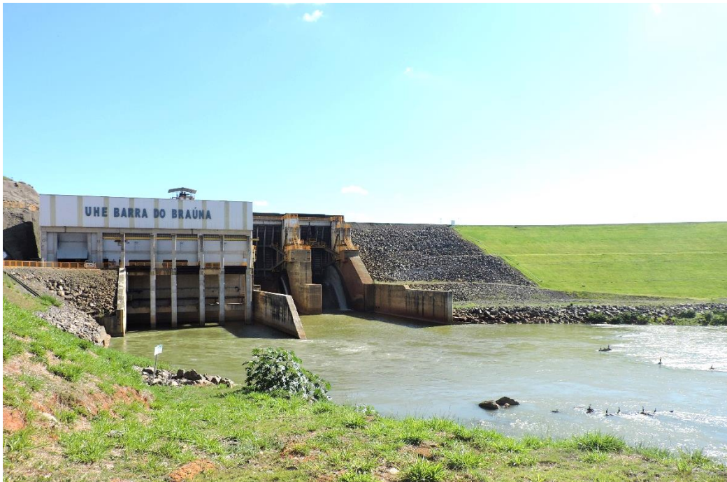
Figura 1 – Instalações da UHE Barra do Braúna
